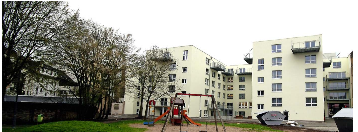
Die Rückansicht der Seniorenresidenz Evergreen in der Neunkircher Bahnhofstraße. Die Grünanlage befindet sich noch in der Fertigstellung.
